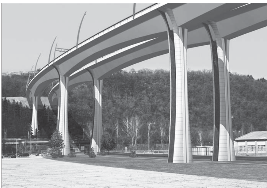
Dálniční křižovatka u Zbraslavi, spojující D1 a D5, patří k nejnáročnějším dopravním stavbám v ČR
